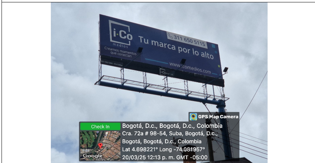
Foto 2. Vista del panel orientación Sur - Norte y de la estructura de la valla, en buenas condiciones y estable.
